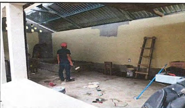
APLICACIÓN DE PINTURAS EN EL INTERIOR Y EXTERIOR DE LA COCINA
