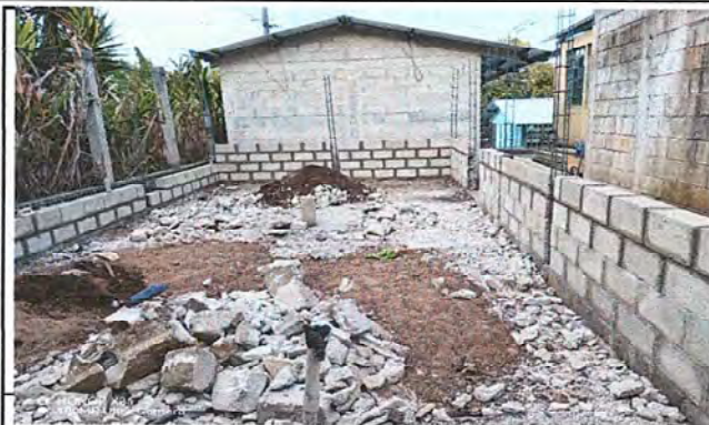
CONSTRUCCION DE LA COCINA
