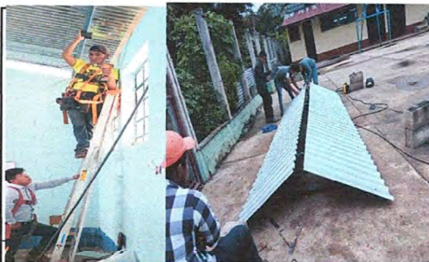
INSTALACION DEL SISTEMA ELECTRICO Y ENTUBADO DE PUERTON
