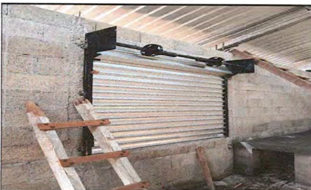
INSTALACION DE VENTANAS
