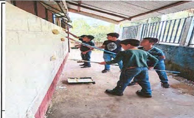
APLICACIÓN DE PINTURAS
